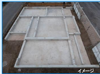
体感2 基礎現場見学
