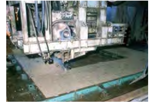
コンクリートパネルを工場生産。
