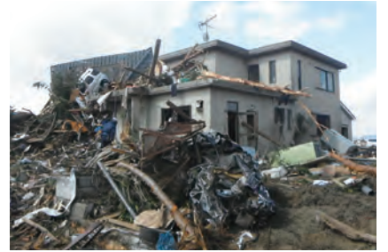
東日本大震災の地震と津波に耐えたパルコン。
