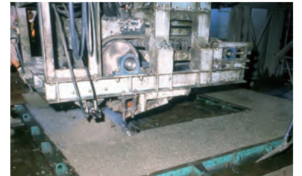
コンクリートパネルを工場生産。
