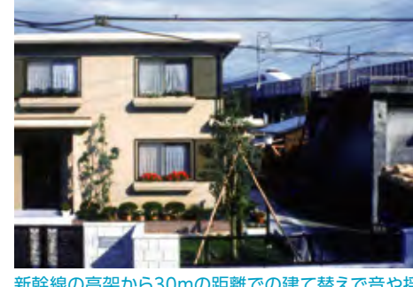
新幹線の高架から30mの距離での建て替えで音や揺れが相当小さく感じると評価をいただいたパルコン。
