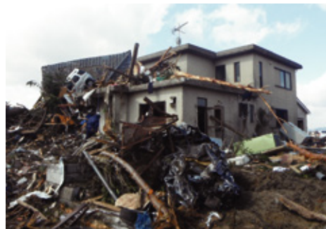
東日本大震災の地震と津波に耐えたパルコン。
