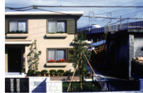
新幹線の高架から30mの距離での建て替えで音や揺れが相当小さく感じると評価をいただいたパルコン。
