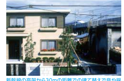
新幹線の高架から30mの距離での建て替えで音や揺れが相当小さく感じると評価をいただいたパルコン。
