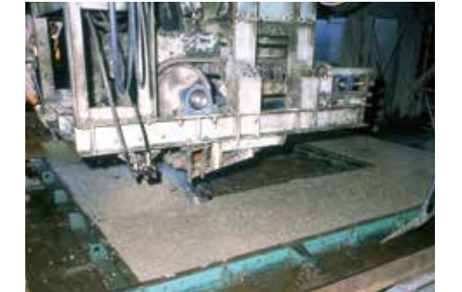
コンクリートパネルを工場生産。
